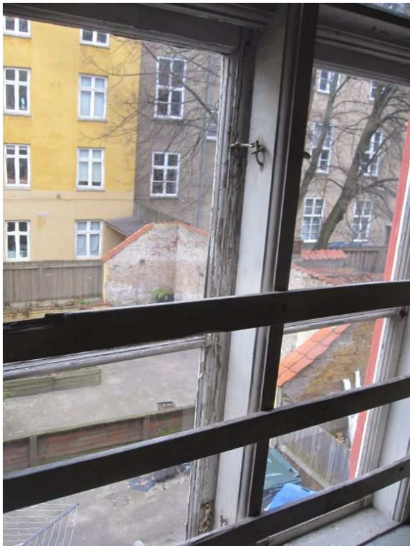
9. Vindue i bitrappetårn 6A. Vinduer fremstår i malikngsmæssig dårlig stand.
