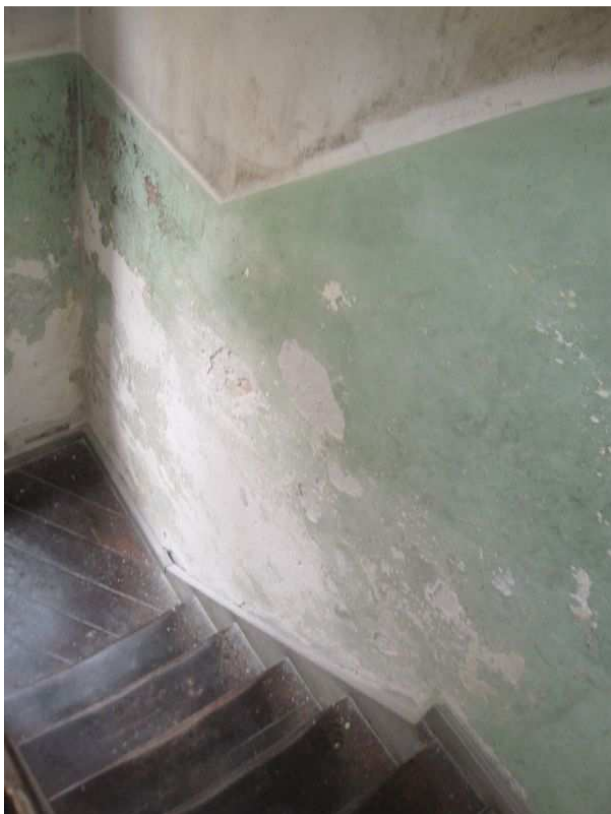
13. Bitrappetårn 6A: Vægge trænger til maleristandsættelse.
