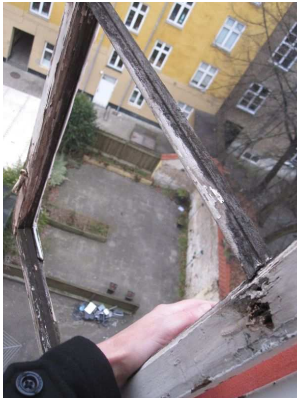
10. Vindue øverst i bitrappetårn, 6A: Trælister i vindue er i meget dårlig stand, vinduesglas er faldet ud. Hér udksiftes vindue med nyt.
