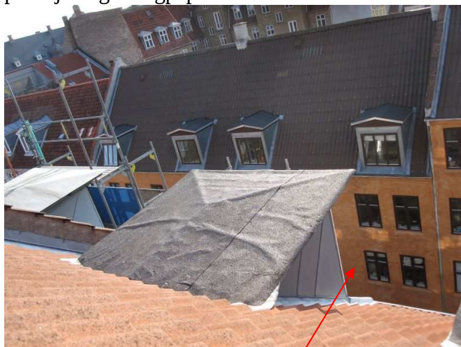
2. Tagpapbeklædning på kvisttage fremstår med dampbuler, manglende vedhæftning til underlag. Underlag har sandsynligvis været fugtigt ved påsvejsning af tagpap.
