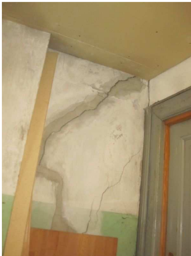
14. Øverst i bitrappetårn 6B: Sætningsrevne
