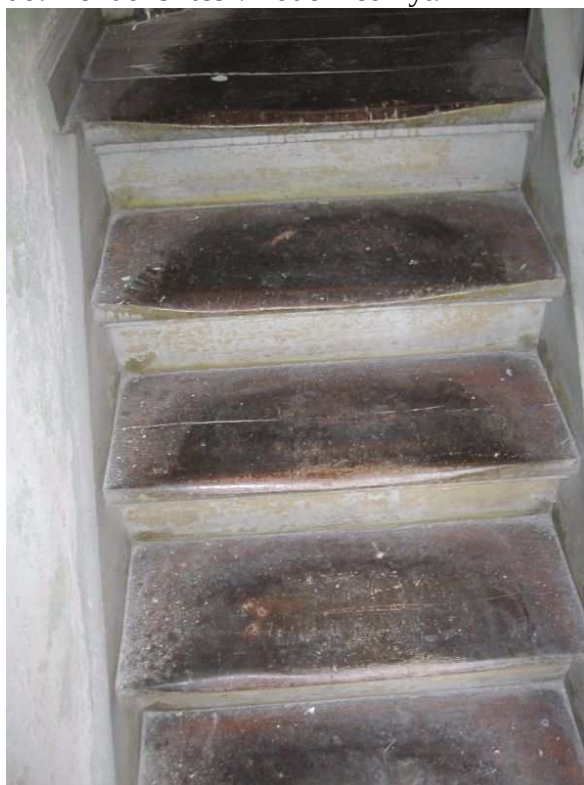
12. Bitrappetårne: Gamle trappetrin er rundslidte.
